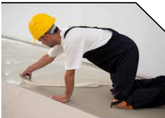
Ospedale S. Anna - Como Lavorazione: rasatura dei sottofondi
